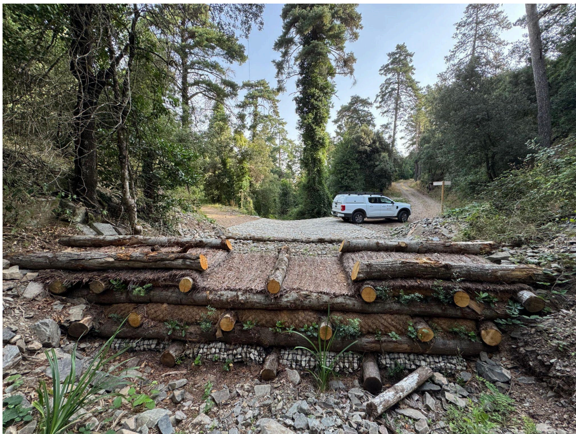
Figura nº2: Imagen donde se aprecia una obra hidrológica forestal en el campo de la bioingeniería en el Paraje Natural de Poblet (Cataluña). Año 2025. (Fuente: REMP).
