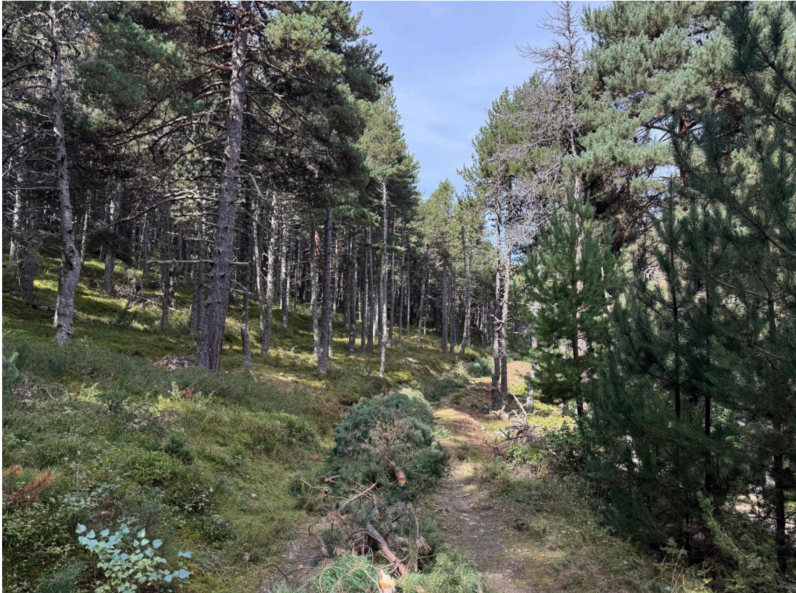
Figura nº3: Imagen donde se visualiza una de las muchas actuaciones de recuperación de pistas forestales, concretamente el acordonado de restos vegetales para la posterior trituración (Autoría: REMP, año: 2025).
