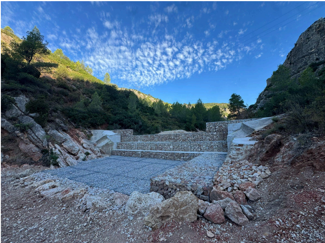
Figura nº1: Imagen donde se aprecian las actuaciones de rehabilitación de un dique. Año: 2025. Autoría: REMP).
