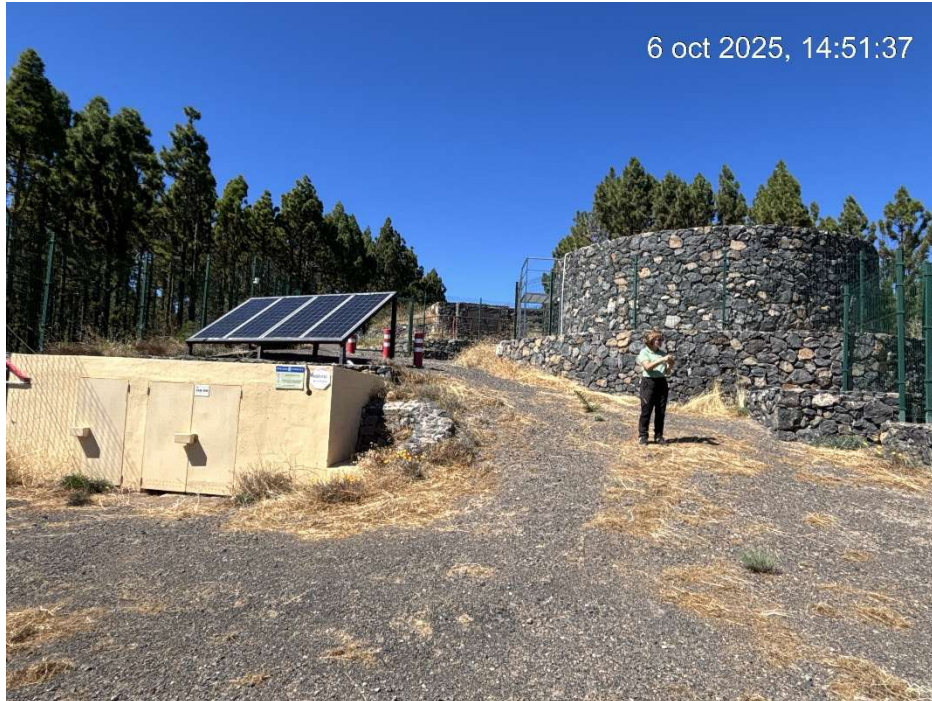
Fig. 4. Depósito de carga con muro de mampostería volcánica, sensorización y paneles fotovoltaicos al fondo. Foto: REMP / Cabildo de Tenerife, octubre 2025
