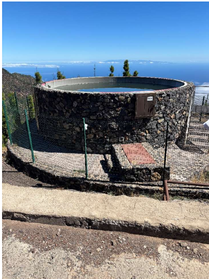
Fig. 1. Depósito de carga de helicópteros con revestimiento de mampostería volcánica, situado por encima del mar de nubes. Foto: REMP / Cabildo de Tenerife, octubre 2025
