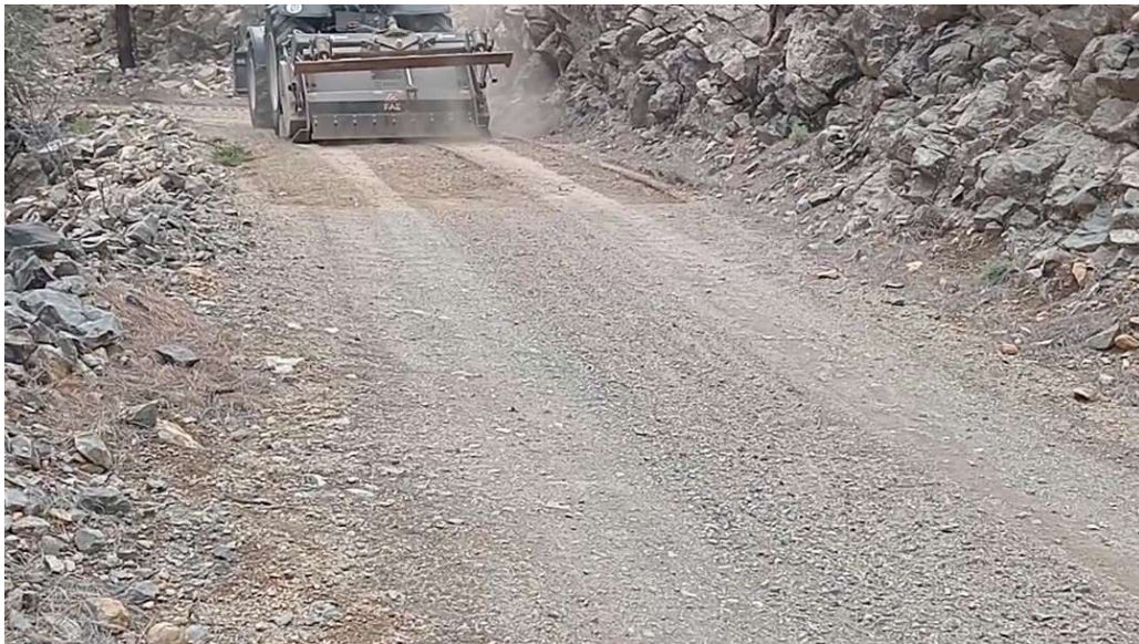
Fig. 2. Maquinaria de compactación trabajando en la restauración de una pista forestal post-incendio. Se aprecia la escollera de protección del margen. Tenerife, abril de 2025.
