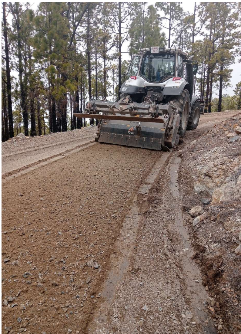
Fig. 1 Stone crusher en funcionamiento durante los trabajos de restauración de pistas forestales post-incendio. Abril de 2025.
