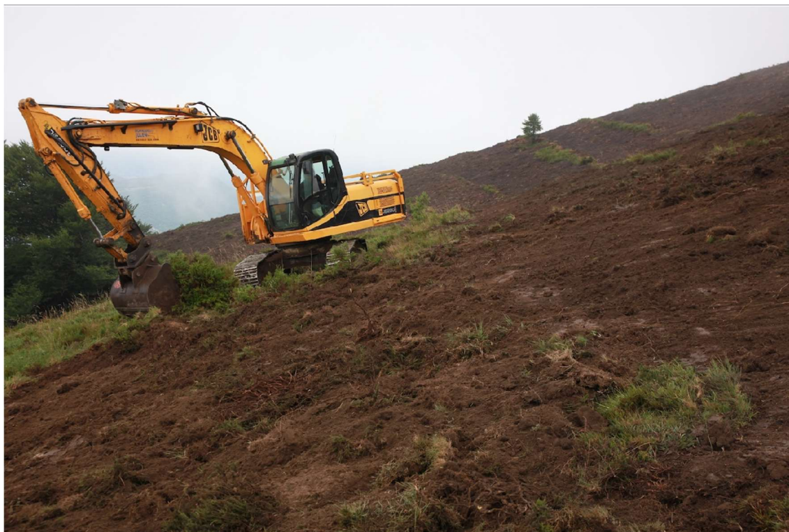
Figura 1. Trabajos de restauración topográfica efectuados con una retroexcavadora con culo, lo que limitaba sus movimientos en las zonas de pendiente más pronunciada. No obstante, el resultado con esta máquina fue excelente, gracias a la pericia del operario. Eso sí, el rendimiento se resiente donde la máquina no puede girar libremente. Gijano, Burgos.
