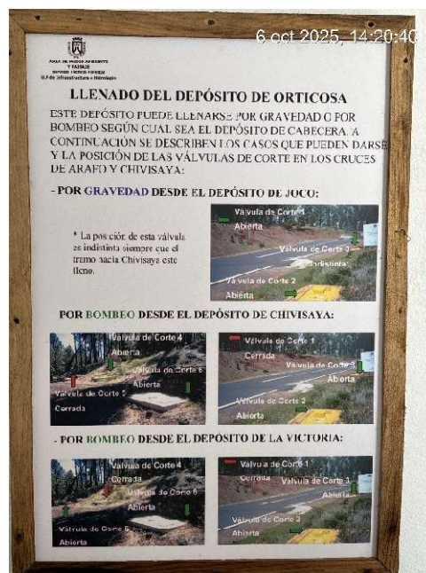
Fig. 3. Panel explicativo instalado en el depósito de Orticoso con los procedimientos de llenado por gravedad y por bombeo desde los distintos depósitos de la red. Foto: REMPE / Cabildo de Tenerife, octubre 2025
