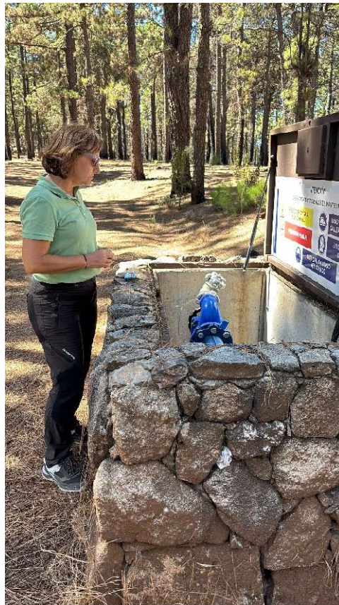
Fig. 1. Paloma García Villegas junto a una arqueta de la tubería dorsal con válvula de conexión para medios de extinción. Foto: REMP / Cabildo de Tenerife, octubre 2025
