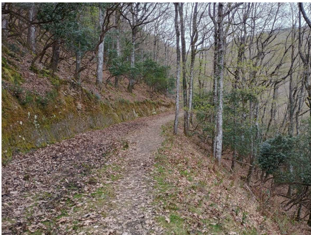
Pista abierta en septiembre de 2013, fotografiada el 2 de abril de 2025. Se ha conservado sin apenas labores de mantenimiento. No se aprecia erosión y sí su naturalización. No tiene cunetas. Gijano, Burgos.
