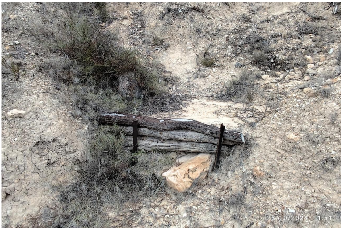
Vista de una albarrada para la corrección de cárcavas. Almería. Autor: Enrique Sánchez. Año: 2.024
